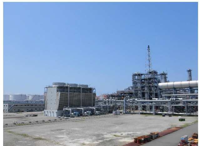
建設予定地写真
