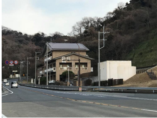
葉山浄化センター
