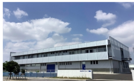
サウスプロダクト外観
