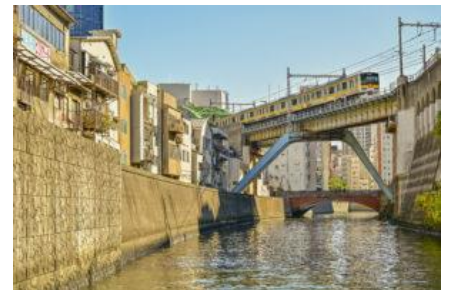
神田川昌平橋と総武線鉄橋
