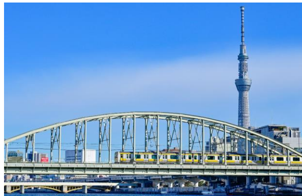
隅田川橋梁(総武線)とスカイツリー
