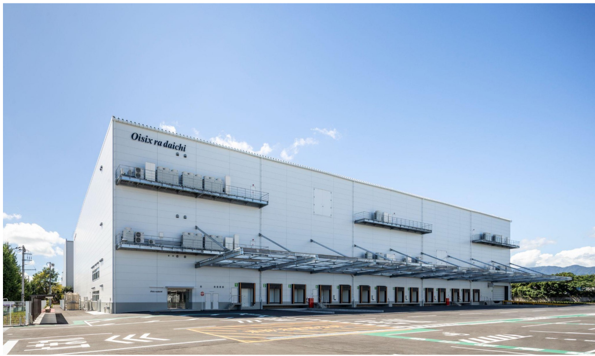
▲ORD厚木冷凍ステーション外観
