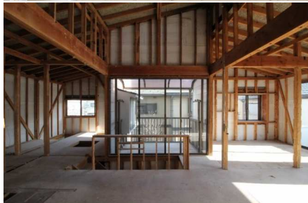
▲遵法性と基本性能を計画したスケルトン状態
