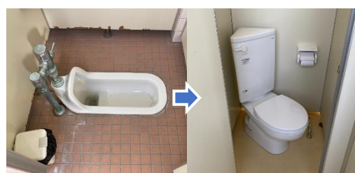
和式トイレから洋式トイレに改修工事
