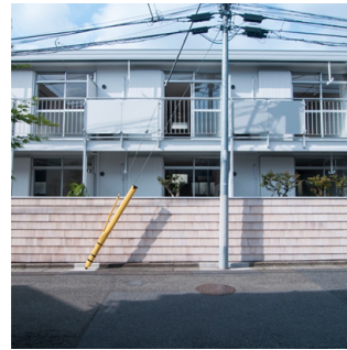
築40年プレハブアパート再生 [さくらアパートメント] 株式会社ブルースタジオ
