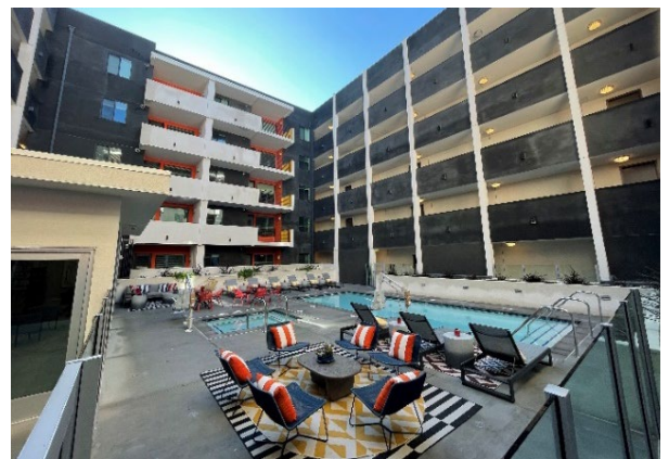
※当社米国物件イングリッドプロジェクト「SORA アpartment」
