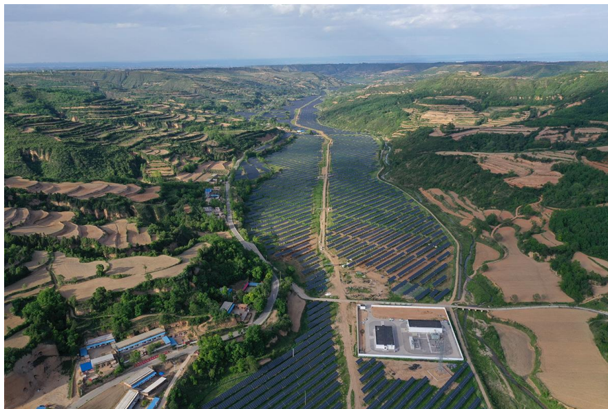
30 MW の Trina Pro スマートソリューションを利用した陝西省銅川市における 中国の「トップランナー」太陽光発電プロジェクト
