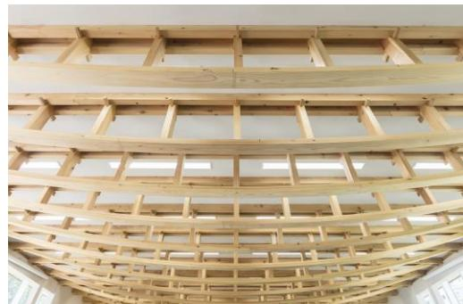
(※)CLT:Cross Laminated Timberの略称で、ひき板を並べた後、繊維方向が直交するように積層接着した木質系の新素材
