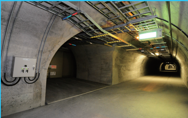
普段入ることが出来ない雁坂トンネルの避難坑
