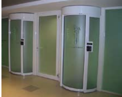
ビル内機密エリアにはサンドガラスを使用
