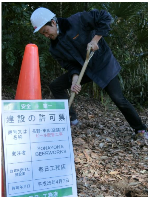
ビール管の建設作業現場
