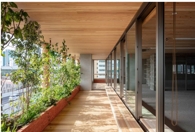
既存の外壁面をセットバックしベランダ空間を創出
