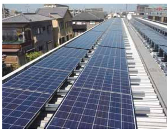
太陽光パネルを設置した集合賃貸住宅の屋根
