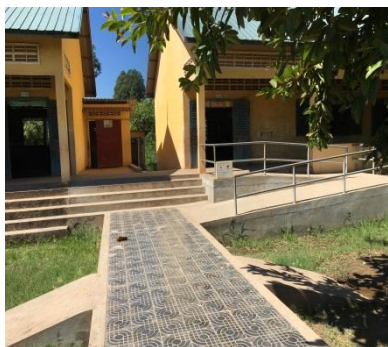
障がい者用通路とスロープ、トイレ
