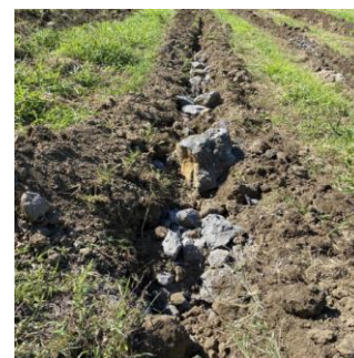
溶岩を取り除き大規模な土壌改良を行う
