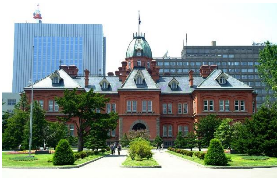
改修工事前の 「北海道庁旧本庁舎（赤れんが庁舎）」
