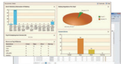
eBIMS 総合監視システム
