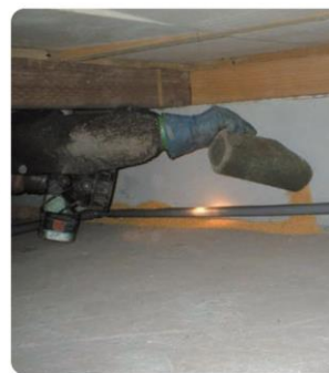
[床下防蟻処理]
