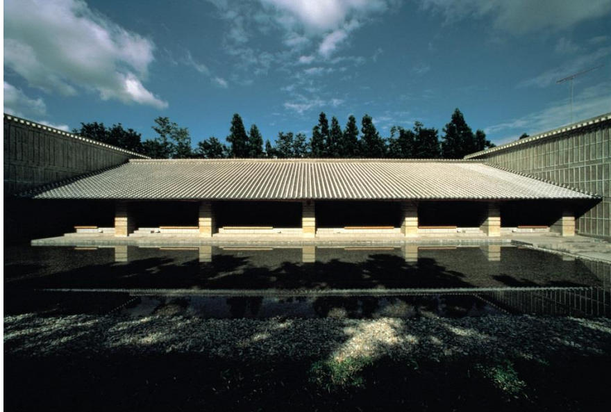
写真：二期倶楽部本館
