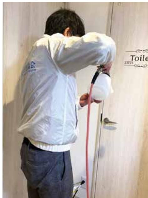
ドアノブにナノゾーンコートを施工します。
