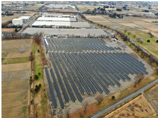
YKK AP 滑川製造所に導入した太陽光発電（両面発電パネル+高反射防草シート）
