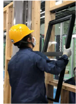
ケドんで吊り込み
