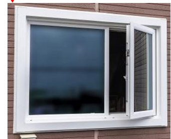
After トリプルガラス樹脂窓 たすべり出し窓+FIX 窓連窓
