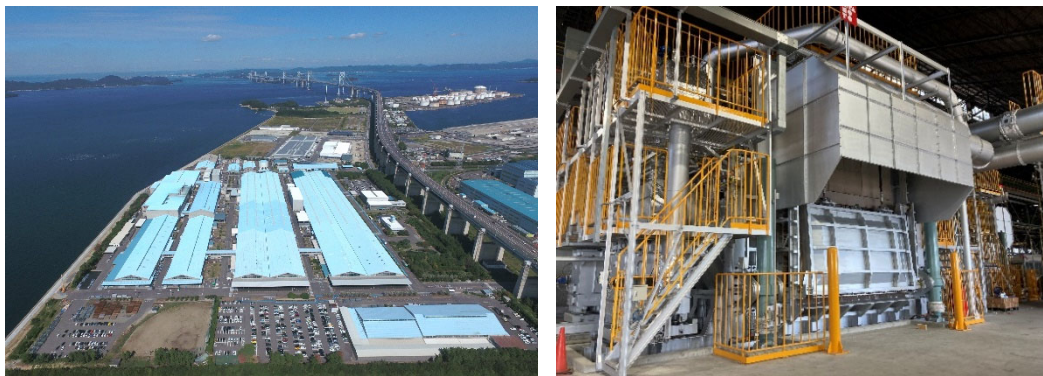
（写真左）四国製造所 外観、（写真右）アルミ溶解炉
