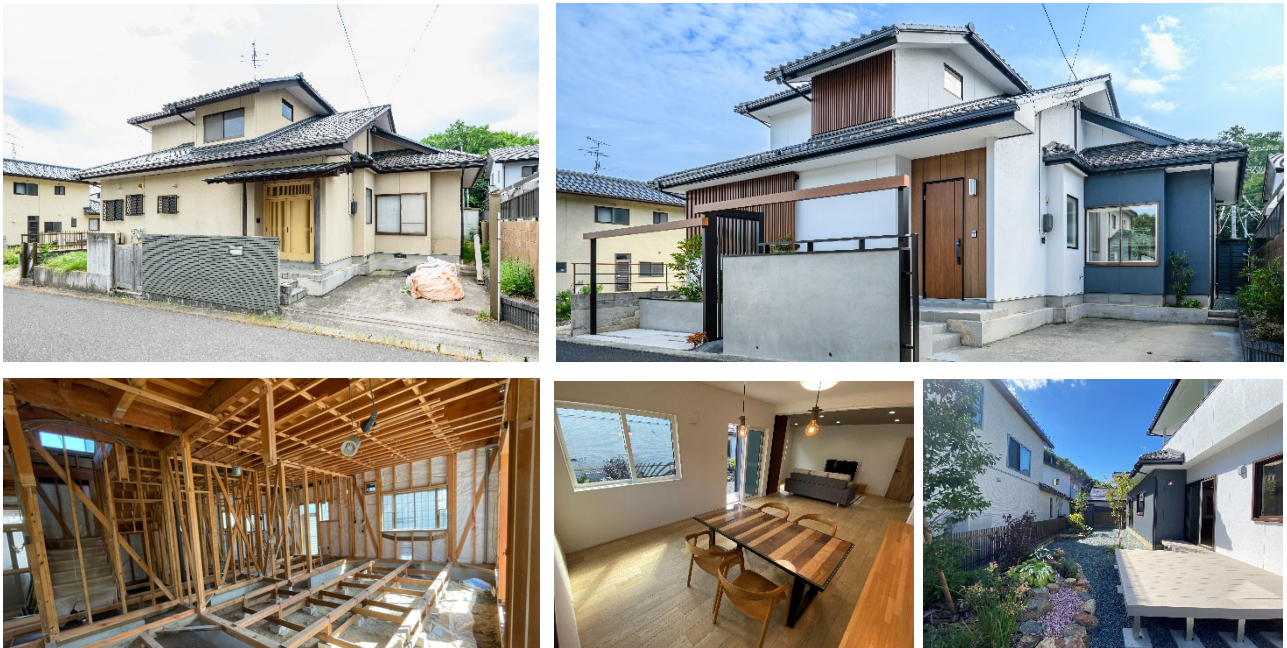
左上：Before、左下：施工中、右：After
