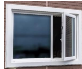
After トリプルガラス樹脂窓 たてすべり出し窓+FIX 窓連窓
