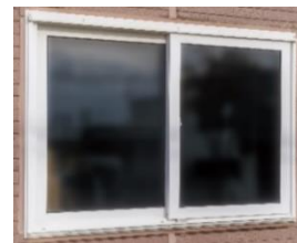
Before 樹脂窓 引違い窓
