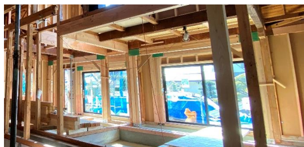
「FRAME II」(門型)設置箇所の様子
