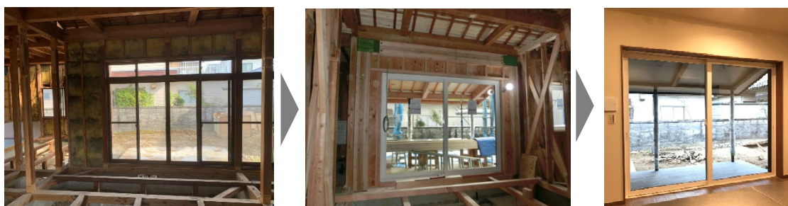
「FRAME II」(門型)設置箇所の様子:(左)解体時⇒(中)施工中⇒(右)After
