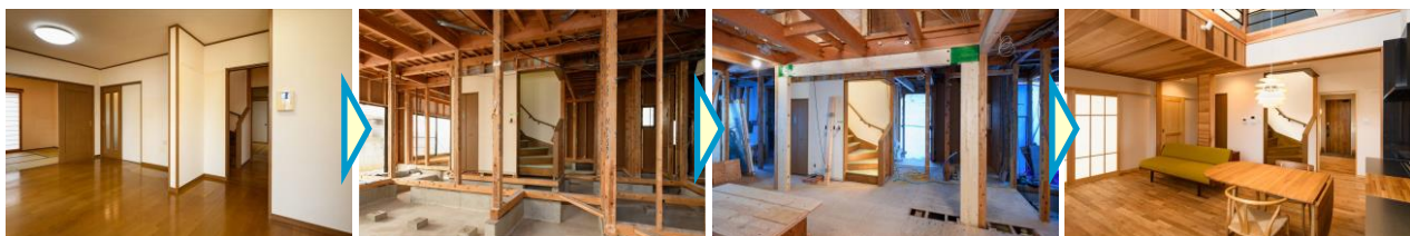
1階の改修前・途中・後の様子(左から、BEFORE ⇒ 改修中[スケルトン] ⇒ 改修中[耐震フレーム] ⇒ AFTER 吹抜け大空間)
