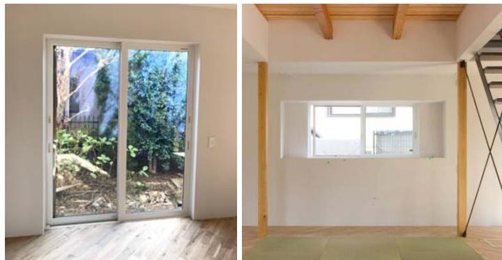
樹脂フレーム+真空トリプルガラスの高性能樹脂窓「APW330 真空トリプルガラス仕様」を採用することで、高い断熱性能と可視光透過率のベストバランスを実現。
