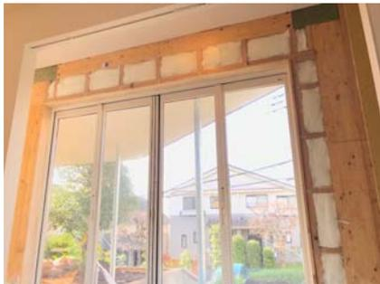
1階の大開口窓2カ所には木質耐震フレーム「FRAME II」を採用。壁を増やさずに開口部を活かしながら、断熱と耐震を同時に実現。
