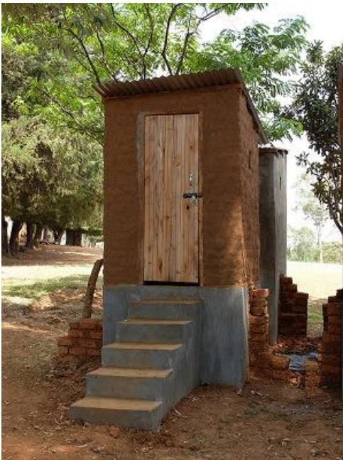
エコサントイレ外観(ケニア)
