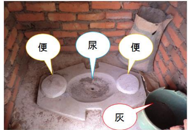
エコサントイレ内部：便と尿を分ける構造になっている。便には植物灰をかけて殺菌する。(マラウイ)
