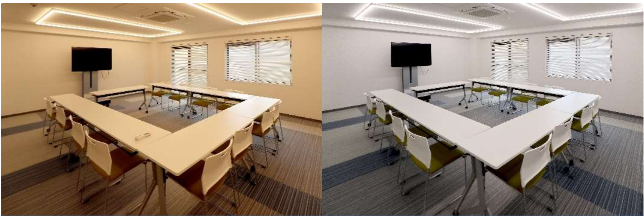
サーカディアン照明による光色の変化（会議室）
