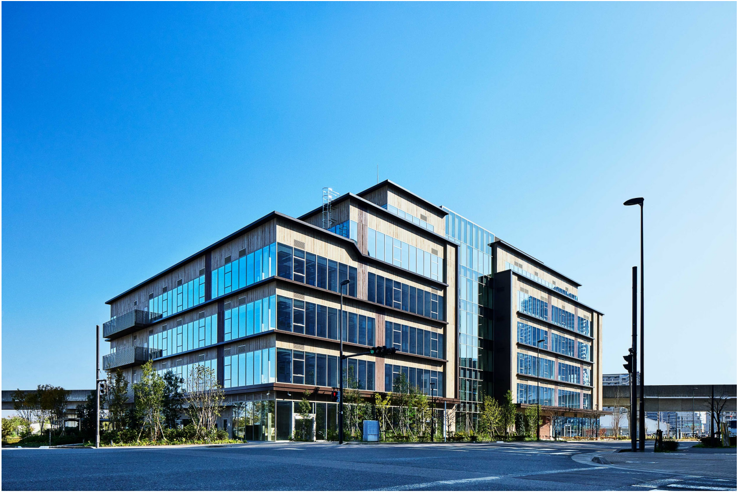
外観 （新たな産業を生み出す企業が集まるイノベーション拠点となるオフィス棟“KOIL TERRACE”）
