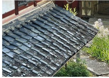
主屋東側庇（屋根修理予定箇所）
