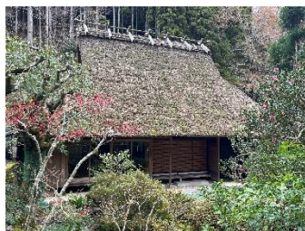
日下部（式部）家住宅 外観
