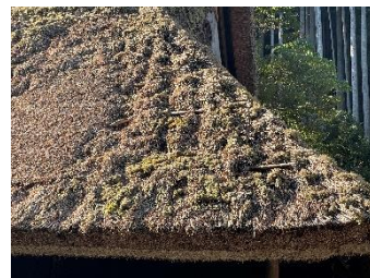
修理予定箇所
