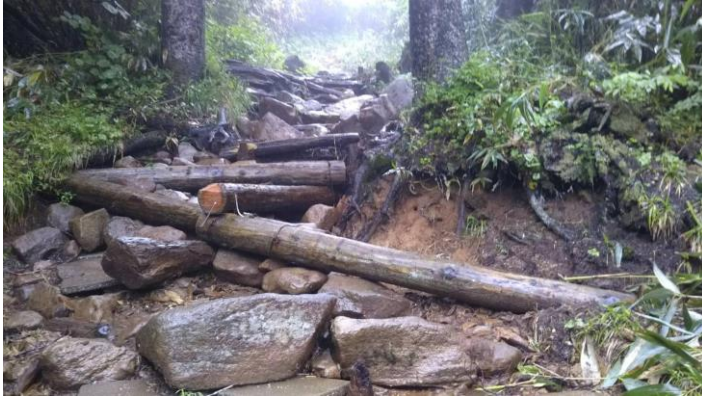
(水の流れを考慮して丸太を斜めに配置する)
