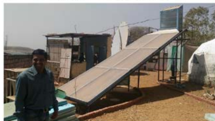
ビギャン・アシュラムで製作、実装されたソーラー温水器／写真：山田浩司
