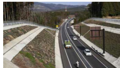
国道57号北側復旧ルート開通
