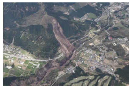
熊本地震による斜面崩壊（南阿蘇村立野地区）
