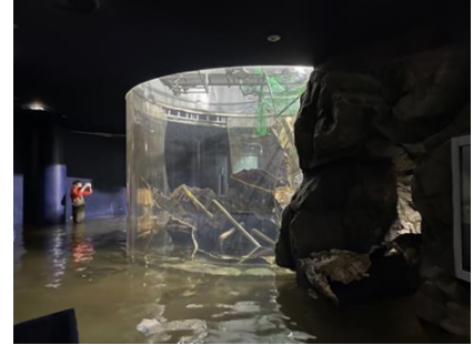
▲破損したビワコオオナマズ水槽
