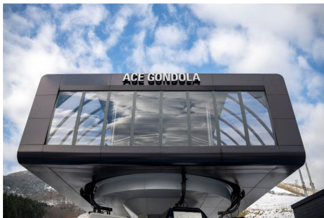
エースゴンドラ山麓駅舎
