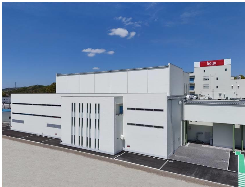
桜が丘工場 第Ⅲ棟 外観
