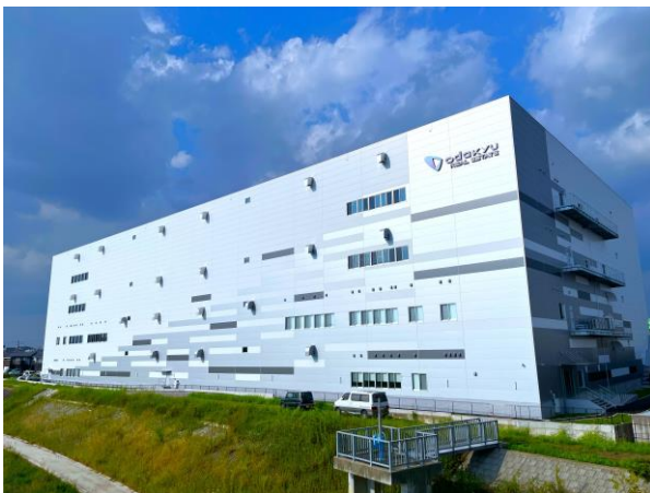
小田急不動産ロジスティクスセンター岡崎 外観
