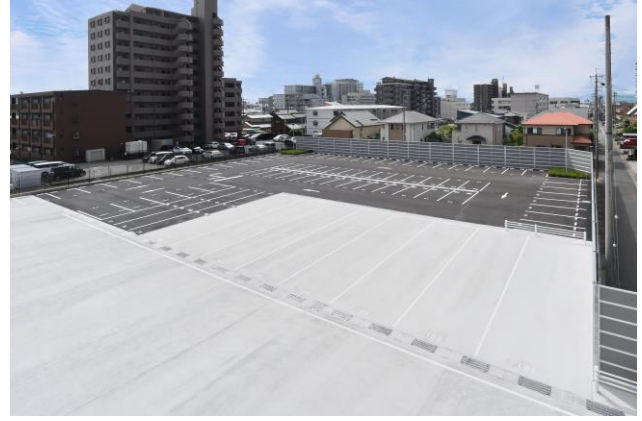
駐車場と大型トラック待機場
