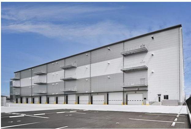
東側トラックバース
