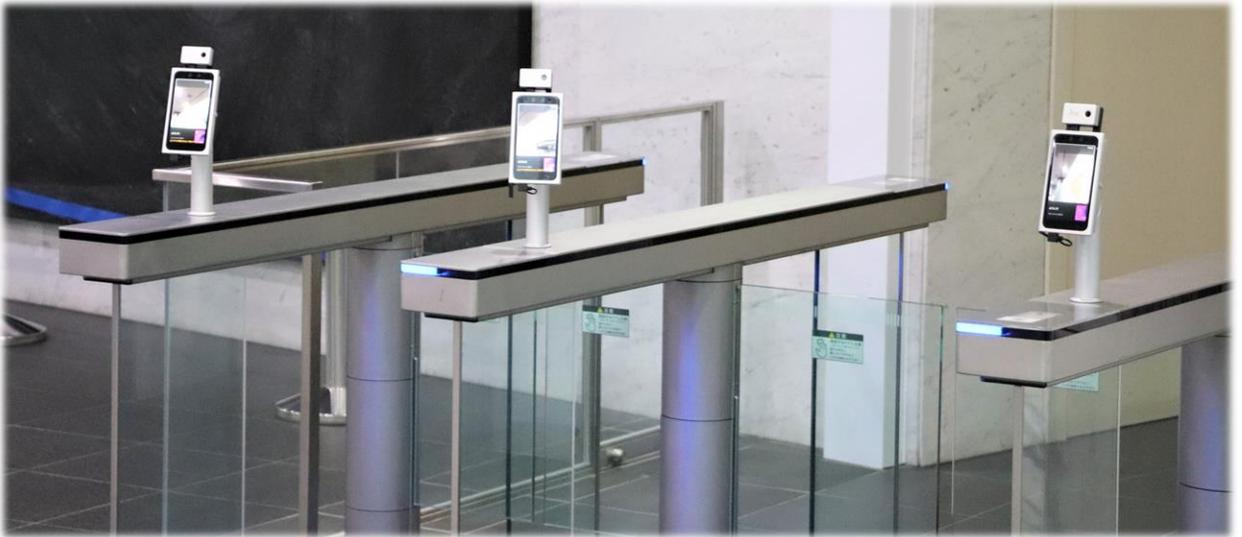
渋谷本社では2021年5月、3ファクタ認証システムとフラッパーゲートを連携させた入退館管理システムを導入しました。登録した「顔」と一致すること、および「体表温」が閾値以下であることで1Fエントランスのフラッパーゲートを通することができ、この情報と各社員の所有する「Beaconタグ」情報のマッチングにより執務室入口の電気錠をタッチレスで開錠できる仕組みとなっています。
