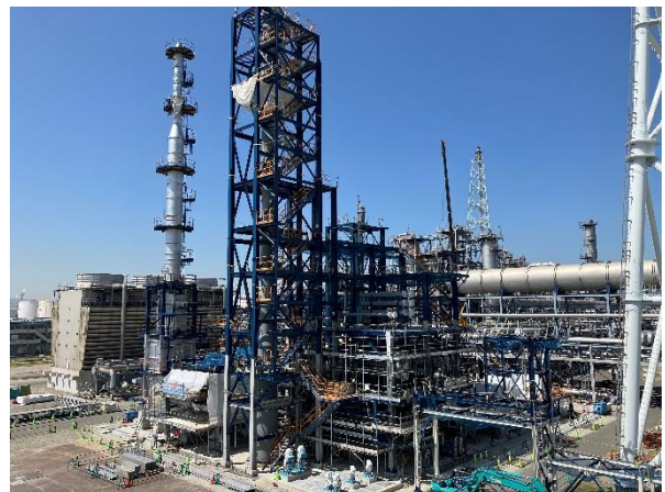
建設中のSAF製造装置（大阪府堺市）
