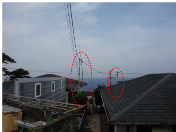
民地内の電柱
