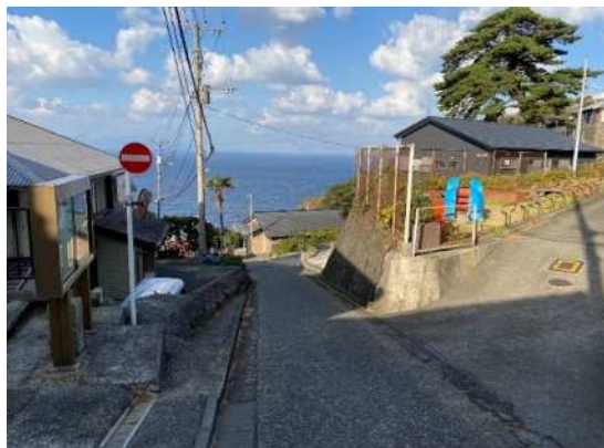
①幅員が狭く急勾配な道路
