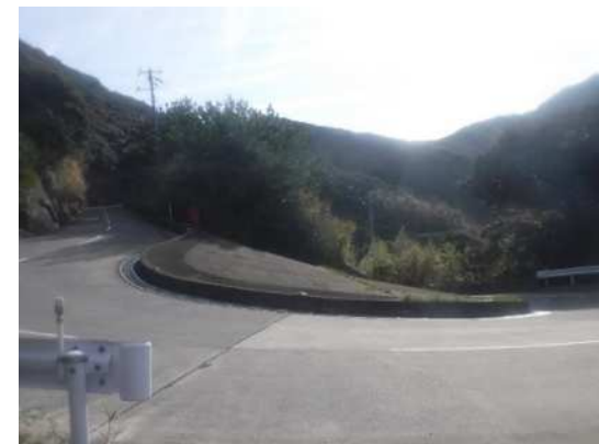
③急曲線の道路
