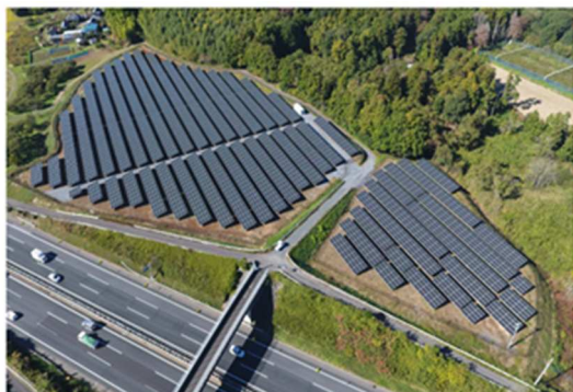
谷向太陽光発電所
