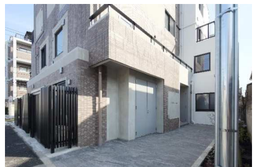
改修後 エントランス位置変更(右奥)
