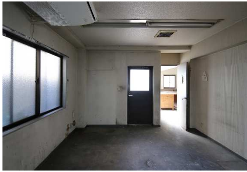
改修前 作業所・事務所部分
